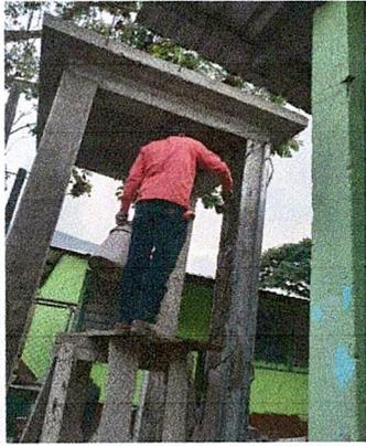
Foto 1: Suministro e instalación de tinaco con su base respectiva mas accesorios
